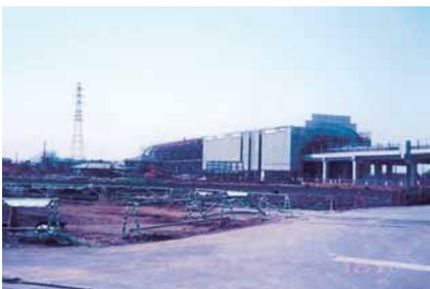
ゆめが丘駅（建設中） 1997（平成9）年3月撮影
