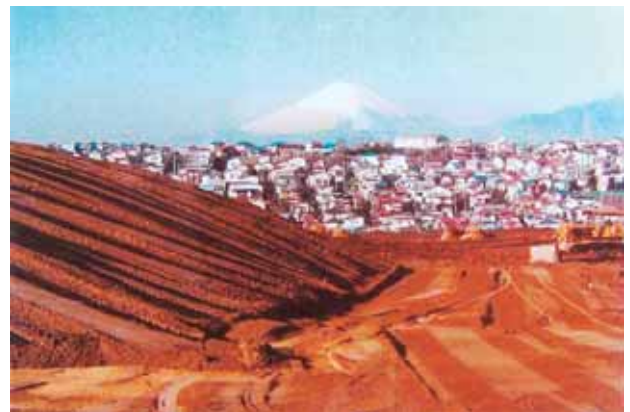
領家地区 宅地造成中 1984（昭和59）年頃撮影
