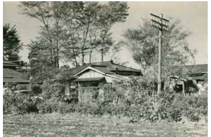
立場交差点北側付近 1958（昭和 33）年撮影
