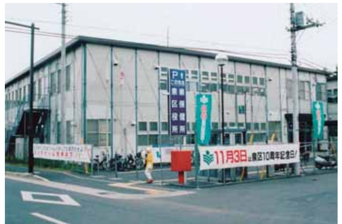
泉区役所仮庁舎 1996（平成8）年撮影
